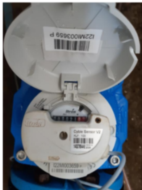
Photos Après Travaux :
