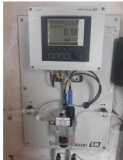
Photos Après Travaux :
