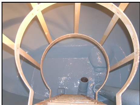
Reprise de l'étanchéité des bassins
