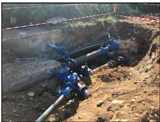
Pose de vannes de sectionnement
