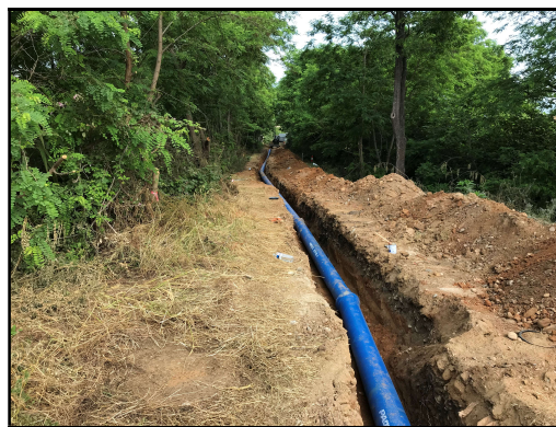
Remplacement de canalisations
