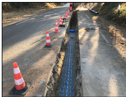
Remplacement de canalisations
