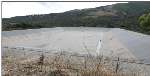
Réservoir de grande capacité 45 000 m 3 de Rogliano
