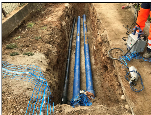
Remplacement de canalisations
