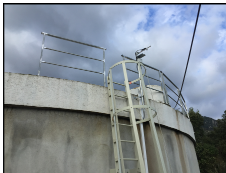
Pose d'équipements pour une accessibilité en sécurité
