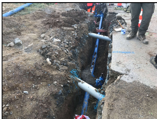
Remplacement de canalisations en site urbain
