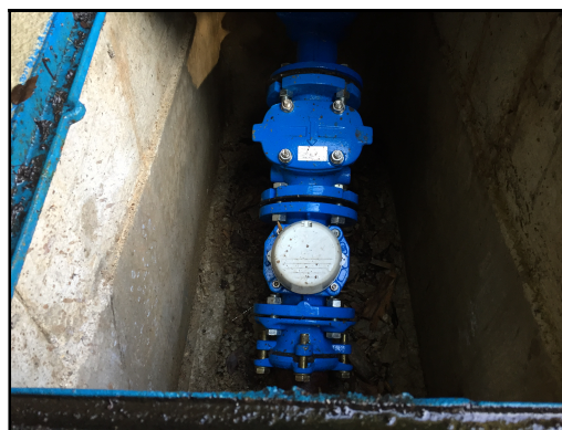
Pose de compteurs d'antenne
