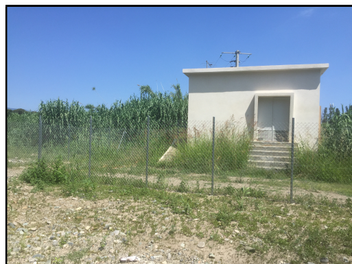
Forage du Fium'Alto
